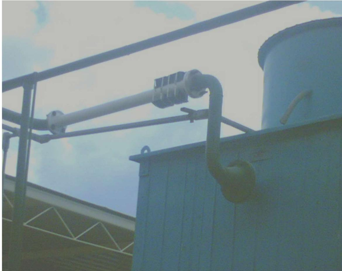
Unidades GMX instaladas en la tubería de alimentación de agua de 4" a una torre de enfriamiento
