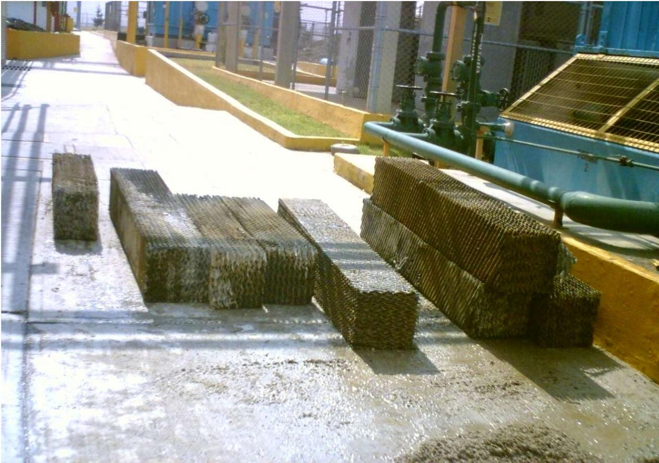
Después de 2 meses de haberse instalado las unidades GMX, se retiró el relleno de la torre para mantenimiento, en la parte de abajo se nota el sarro que ha sido removido con chorro de agua a presión
