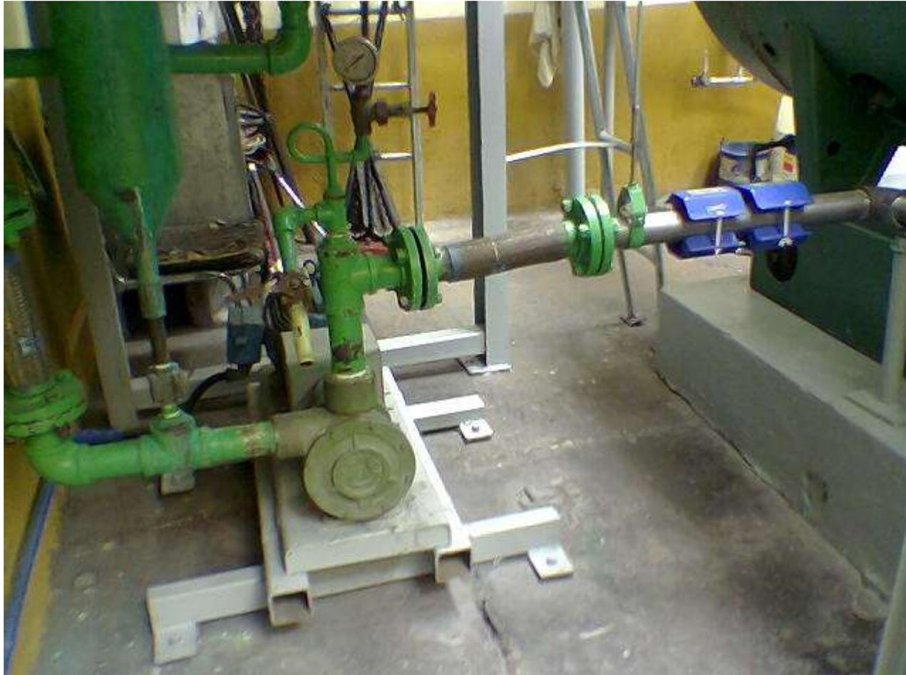
Unidades GMX instaladas en tubería 1-1/2" en la alimentación de agua a la caldera
